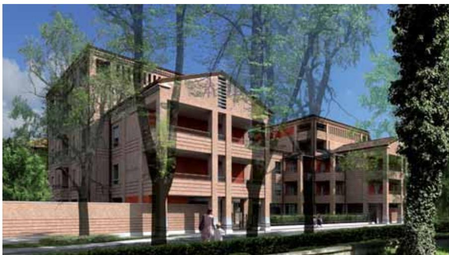
Particolare cura è stata riservata alla scelta dei materiali, che ha onorato la tradizione adottando, quale struttura portante, un'ossatura di travi e pilastri in cemento armato, con solai latero-cementizi.
