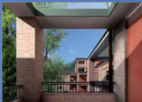
ARTEMIDE: particolare da una loggia
